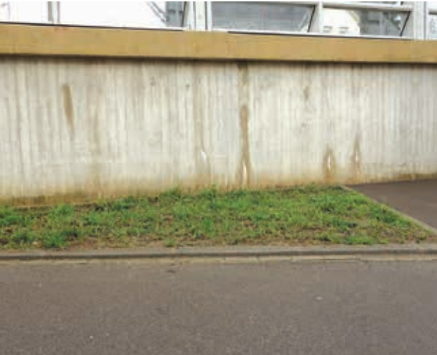
Vor dem Bodenaustausch: Viele Gräser und Problemkräuter befinden sich im Beet.
